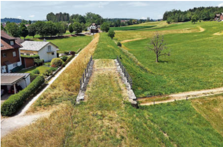
Eine Brücke ins Nichts? Nein, das ist der Bahndamm der alten UeBB-Strecke kurz vor der Station Dürnten (im Hintergrund). Bild: Simon Grässle
