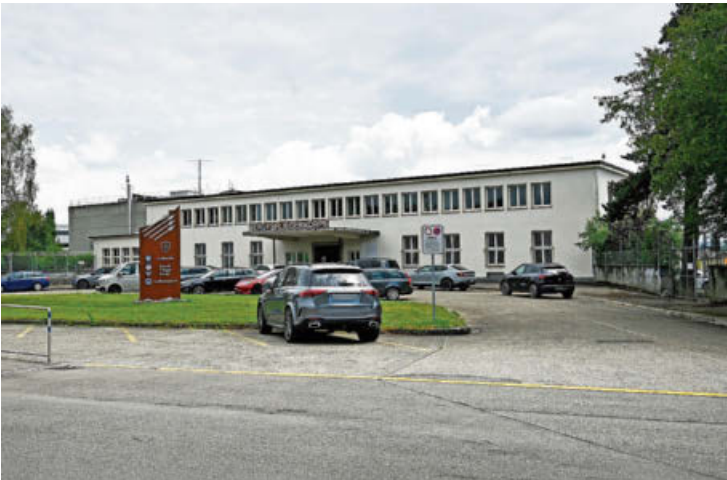
Früher Empfangsgebäude der Swissair, heute Aufnahmegebäude des Berufsflygerkorps. Bild: Simon Grässle
