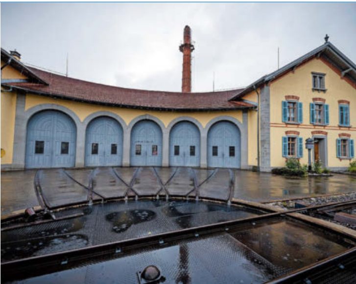
Das Rundhaus beherbergt Platz für fünf Dampflokomotiven, die über eine Drehscheibe gewendet werden konnten. Archivbild: Fabio Meier
