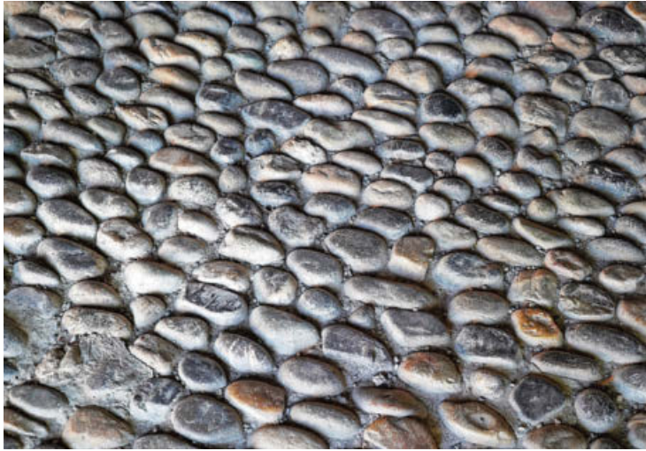
Die in den 1930er Jahren erstellte Katzenkopfpflasterung soll mit der Modernisierung keine Stolperfalle mehr sein.
