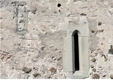
Abb. 17: Fassadenputz am Ritterhaus mit Einritzungen.
