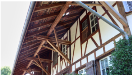
Abb. 20: Kleine Riegelflächen aussen am Ritterhaus.
