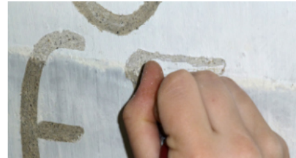
Abb. 24: Auskratzen der Darstellung. Oben bereits trocken (Vortag), unten frisch und deshalb noch bearbeitbar.
