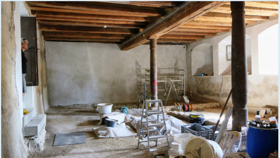
Kellerraum H 035 im Bauzustand.
