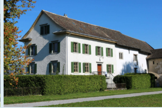
Abb. 9: Innenhof des Ritterhauses.
