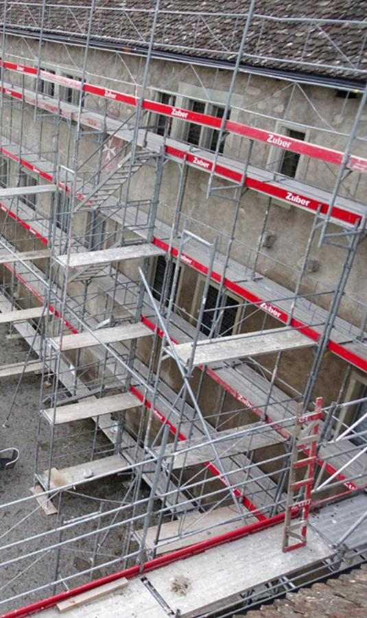
*Aufwendige freistehende Gerüstkonstruktion, ohne Kontakt zum Gebäude. (Bild: RHG)*
