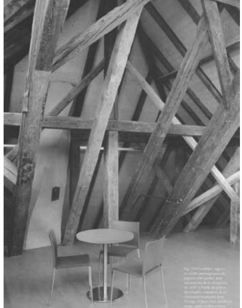
Im Dachgeschoss mit sichtbarer Holzkonstruktion wurde die reichhaltige Bibliothek eingerichtet.
