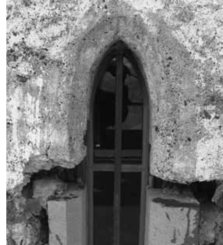
Abb. 3 Linkes Spitzbogenfenster mit Resten der grauen Ausfassung
