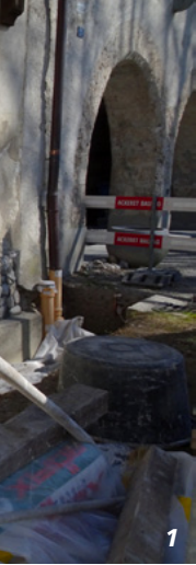
1 Fundamentsockel der Kapellenwestseite.
