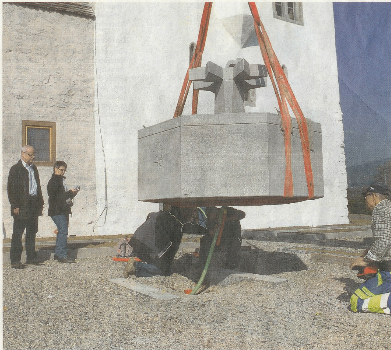
Viel Präzisionsarbeit: das Einsetzen des neuen Brunnens im Kräutergarten des Ritterhauses. Bild: Nicolas Zorvi
